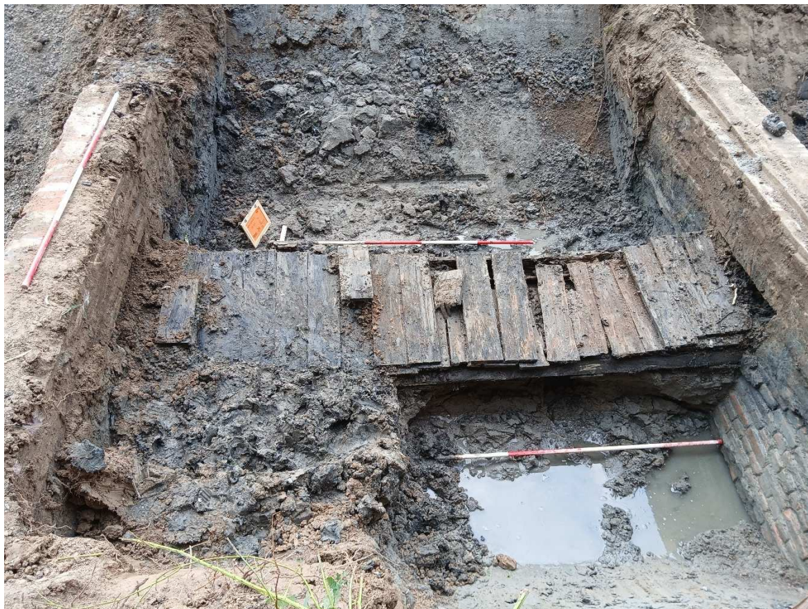
Afbeelding 32 De twee muren van de 19 e /20 e -eeuwse duiker met daartussen de goot. Bron: Vestigia 2025.
