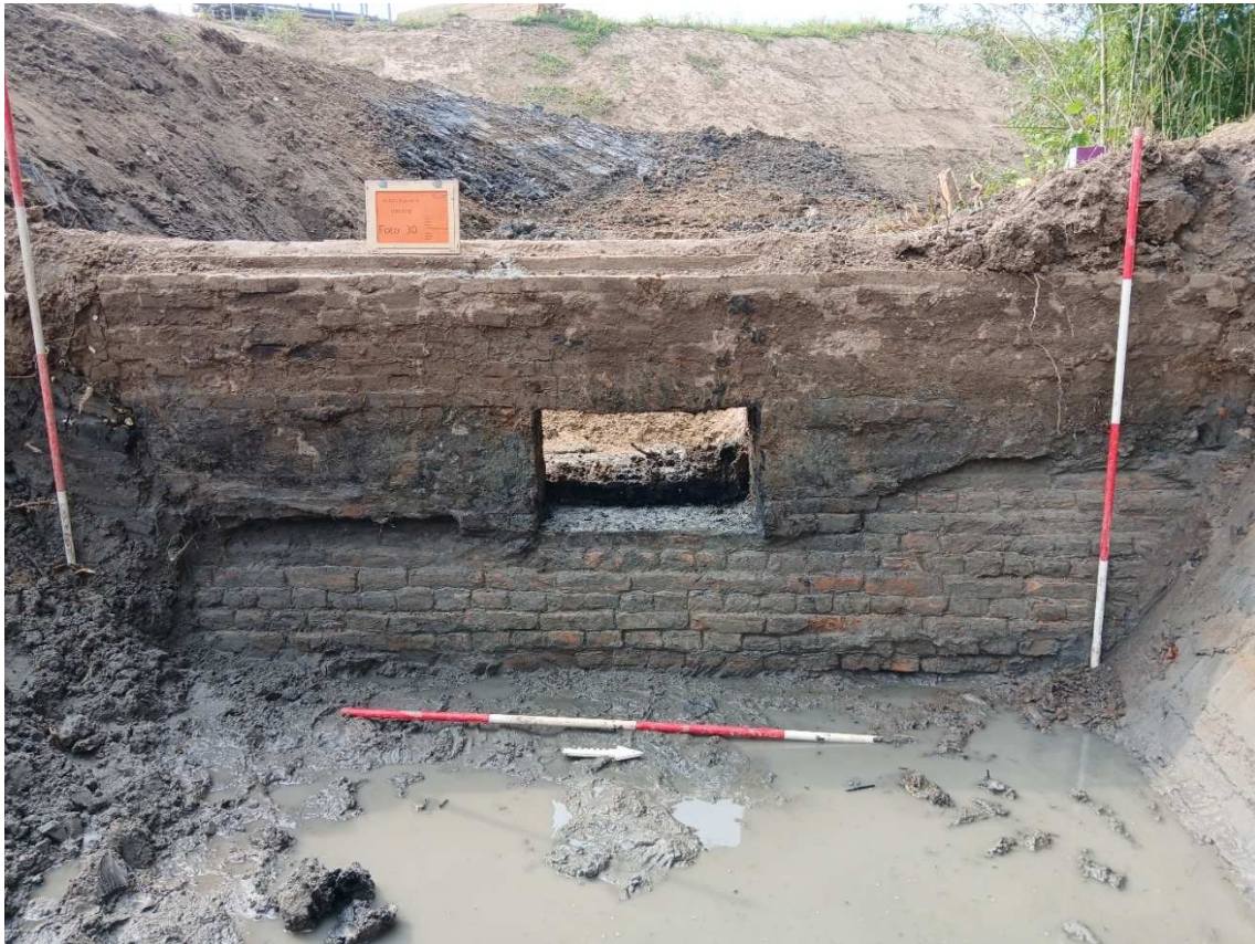
Afbeelding 33 Na het verwijderen van de goot was duidelijk zichtbaar dat de westelijke muur van de duiker (S7001) direct op en in verband met middeleeuws muurwerk is aangelegd. Bron: Vestigia 2025.
