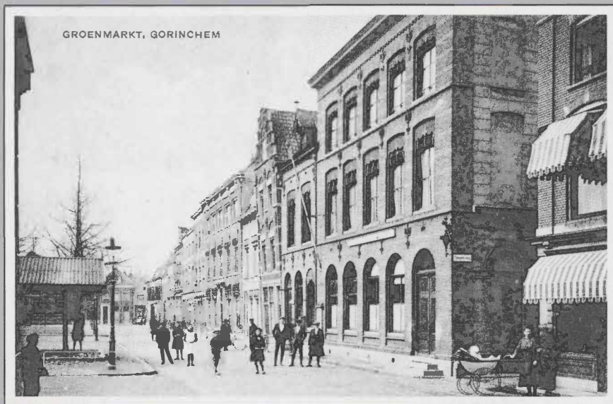
Het voormalige Post- en Telegraafkantoor aan de Groenmarkt op de hoek van de Tinnegietersteeg, waarin van 1918 tot 1930 de bibliotheek was gevestigd.
