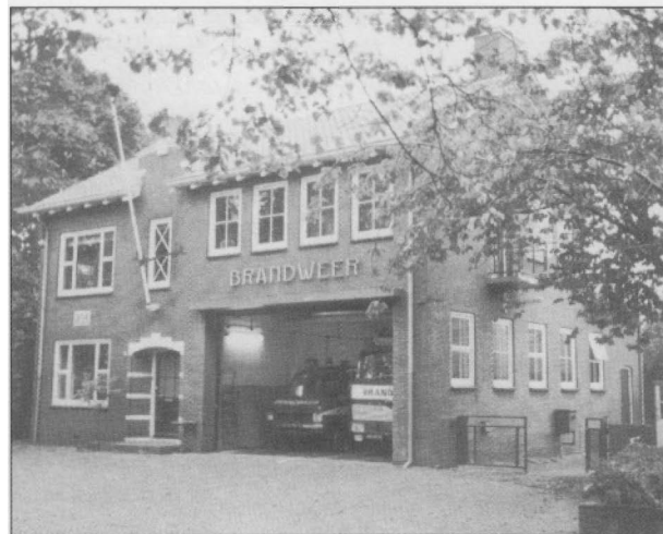
De brandweerkazerne aan de Vlietlaan, in de jaren vijftig. De brandweer vond hier onderdak bij de politie.
