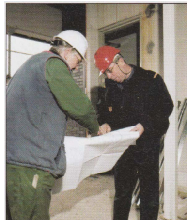
De nieuwbouw krijgt vorm.
