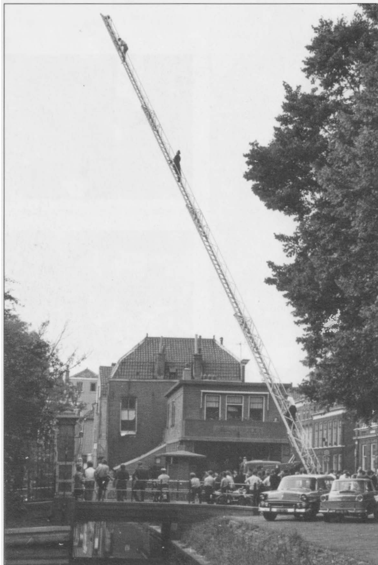
De brandweer in actie voor het gebouw in de Struisvogelstraat, 1969.
