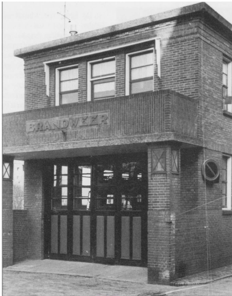
De nieuwe brandweerkazerne in de Struisvogelstraat. De garagedeur die moest worden opengeklapt, werd later vervangen door een roldeur.
