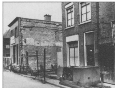
Het gebouw in de Dalemstraat wordt op 10 mei 1957 10 meter opzij en 1,25 meter naar achteren verplaatst.
