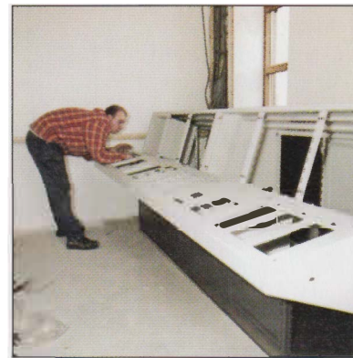
De nieuwe technische ruimten worden ingericht.
