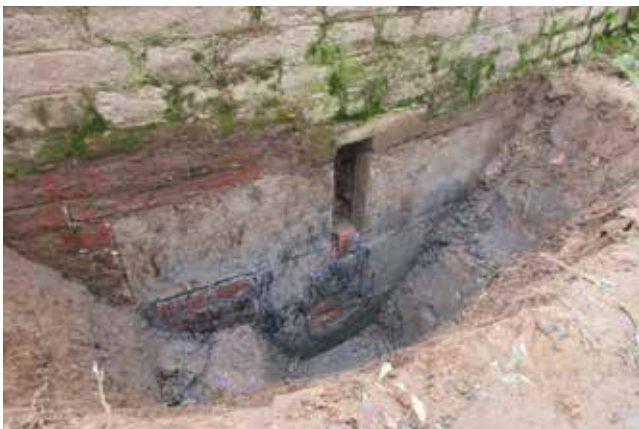
Afb. 10 Het vrijgelegde middelste schietgat van de hoektoren van de hoofdburcht. Herkenbaar is de verticale smalle kijksleuf met eronder de dichtgezette ronde schietgatopening voor een kanon. Kijksleuf en schietgatopening zijn met Gobertange steen afgewerkt. De top van het tegen de dichtgezette kijksleuf en schietgat opgeworpen dijklichaam tekent zich af als een zwarte horizontale grens. Foto: auteur 2017.
