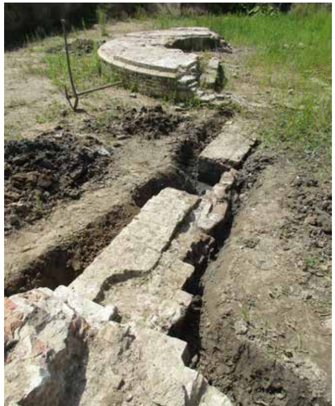
Afb. 12 Muurwerk van de beer, met waterdoorlaat, met op de voorgrond de bouwmassa van de gevelhoek van de schildmuur van de voorburcht en op de achtergrond het restant van de ronde hoektoren van de hoofdburcht. Het muurwerk van de beer is in een later stadium aan de binnenzijde verzwaaard, waarbij de waterdoorlaat grotendeels is dichtgezet. Foto: auteur 2017.
