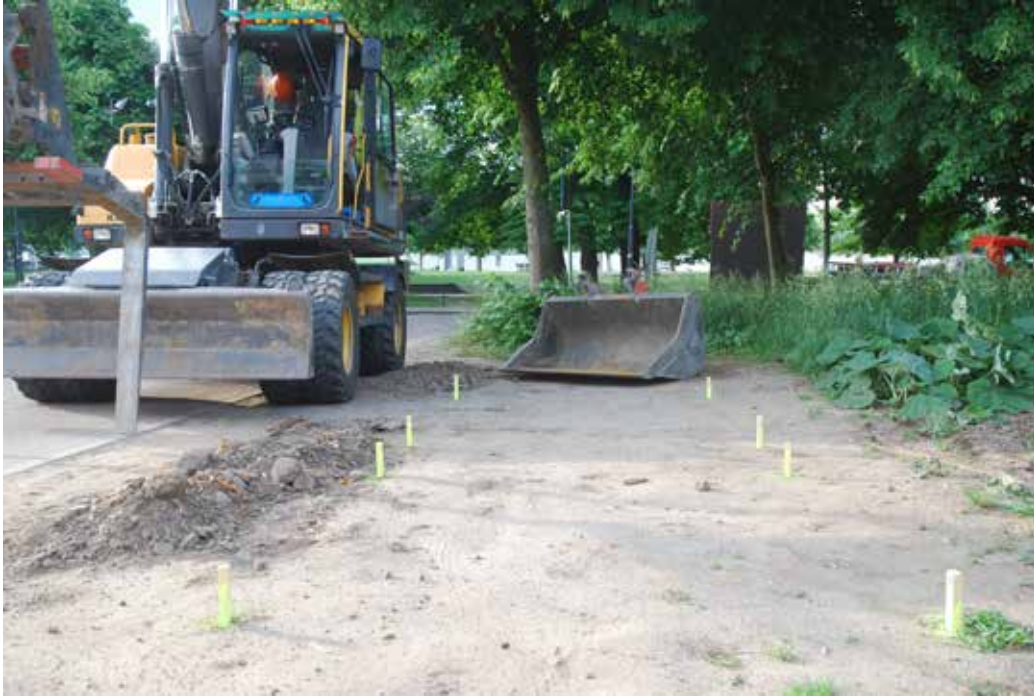
Afbeelding 4. Opname van de situatie voor de plaatsing van de ondergrondse containers. De kijkrichting is naar het zuidoosten.
