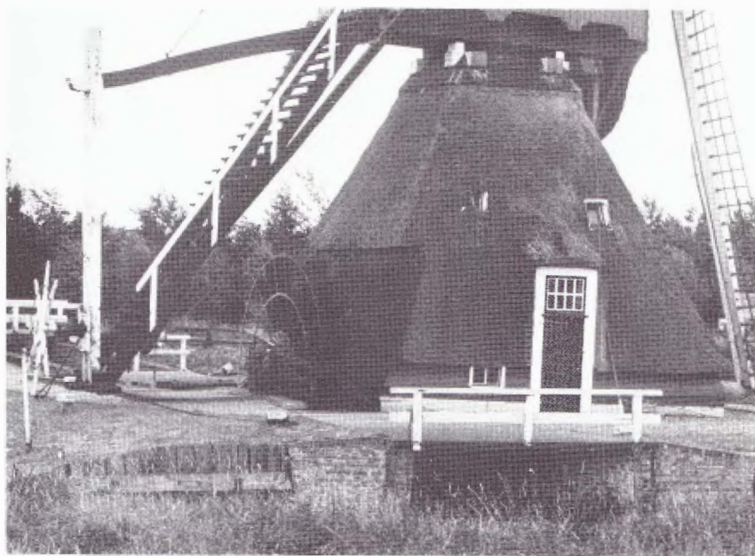
Onderbouw van een wipwatermolen met waterloop.
