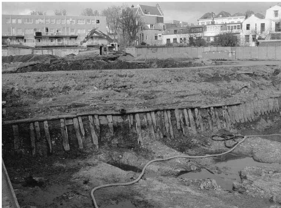
Afb. 47. Rotterdam – Delfshaven * Stadswerf. Vooraanzicht van een gedeelte van de kadebeschoeiing.
