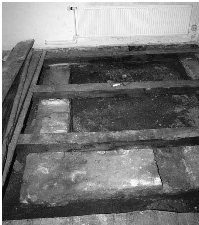
Afb. 11. Amsterdam * Spuistraat 32. De vloerbalken in het achterhuis van Spuistraat 32 rusten op opvallend zwaar metselwerk van een voorganger (foto: Bureau Monumenten en Archeologie, J. Veerkamp).
