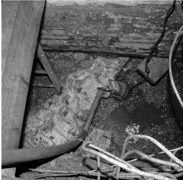
Afb. 6. Amsterdam * Leidsekade. Tijdens funderingsonderzoek in Hotel Lion op de Leidsekade werd metselwerk van het 17de-eeuwse bolwerk Sloten aangetroffen (foto: Bureau Monumenten en Archeologie, J. Veerkamp).
