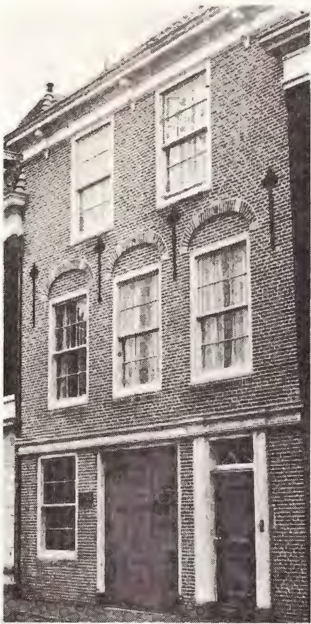
Havendijk 72 na de restauratie.
