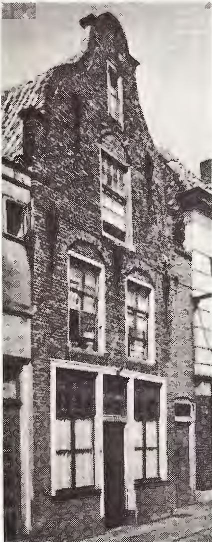
Voor de restauratie
