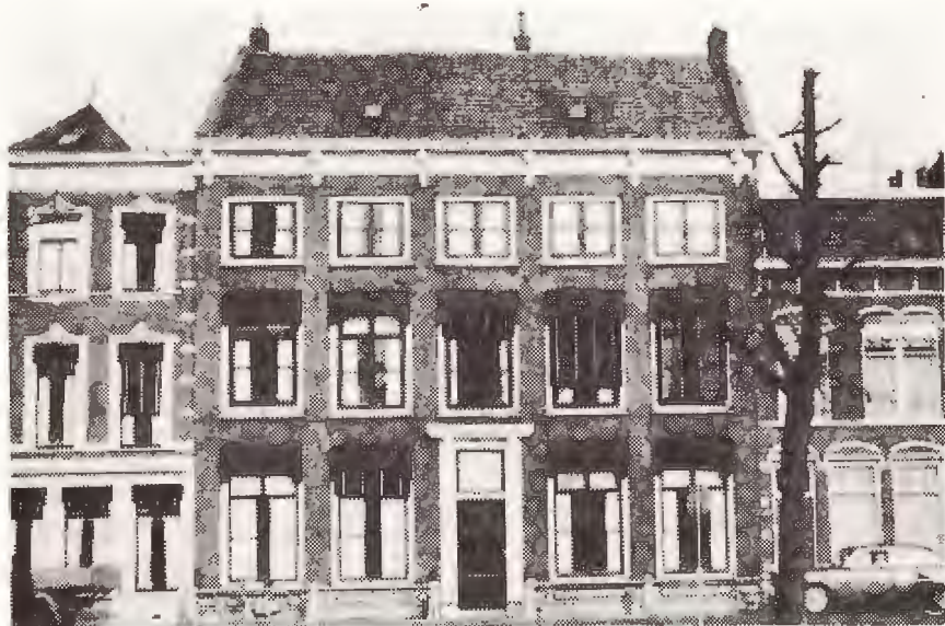
Het gebouw aan de Groenmarkt.
