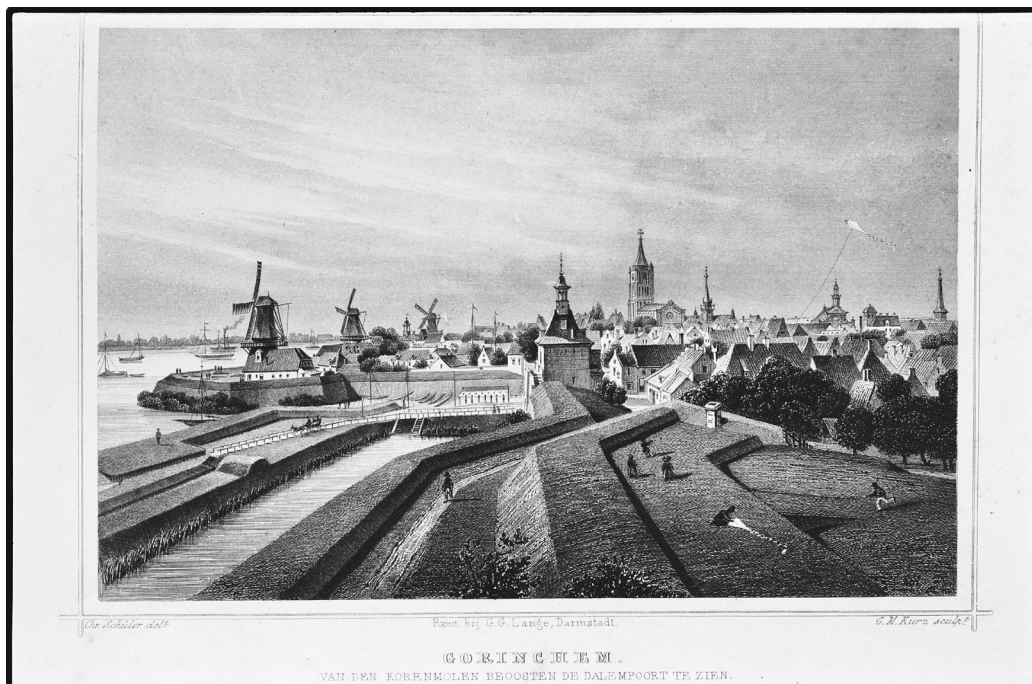
Afbeelding XX. Afbeelding van Gorinchem met daarop het vestingswerk en de bedekte weg tussen de aarden wallen. Met bedekte weg wordt een beschutte weg bedoeld.
