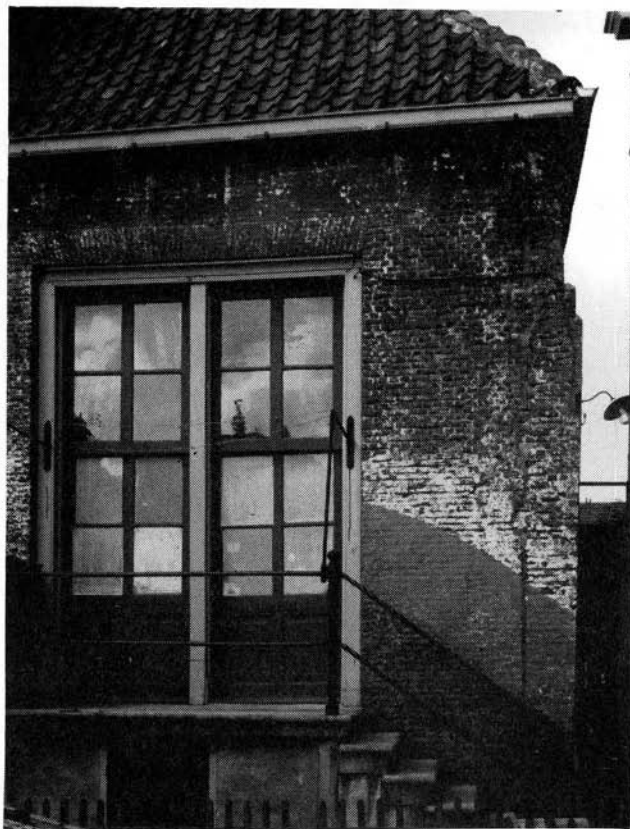
16. Achterzijde van het in 1935 afgebroken pand Torenstraat 15; c. 1933.
