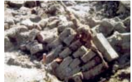
Neergehaalde muurresten en muuranker [mv]
