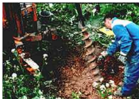
Afb. 2. Boring 5; verhitte avegaar doorboort massieve fundering
