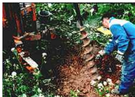
Afb. 2. Boring 5; verhitte avegaar doorboort massieve fundering
