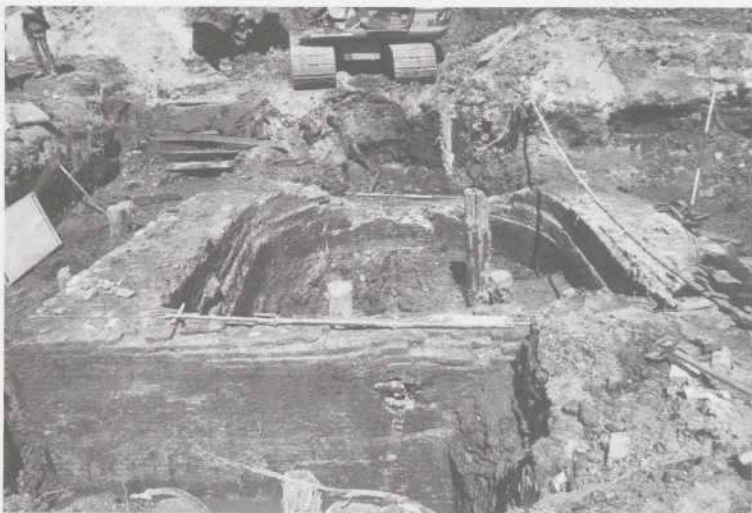
Afb. 17. Hoorn: fundering Geertentoren. Foto Gemeente Hoorn.
