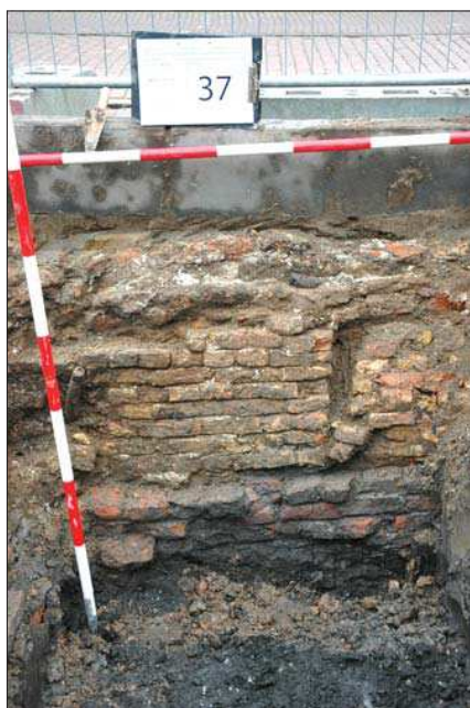
Afbeelding 14: De verschillende bouwfasen onder de (binnezijde van de) voorgevel van pand R117. Foto richting zuiden.
