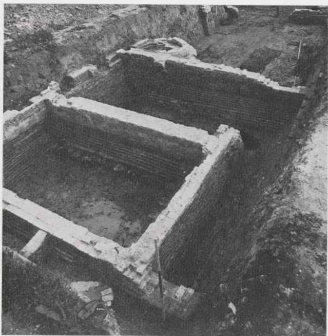
Afb. 25 Dordrecht. Woontoren gezien vanuit het zuidoosten. Binnen de grote en diep gefundeerde oorspronkelijke rechthoek is links een kleinere en gedeeltelijk hoger gefundeerde onderverdeling aangebracht. Op de pleisterlaag binnen deze laatste zijn twee vloerniveaus te onderscheiden. Bij het bovenste niveau behoort de later aangebouwde traptoren buiten de grote omtrek. Foto ROB.
