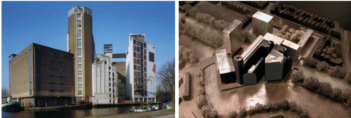
De Meelfabriek Leiden; huidige situatie en foto maquette (foto's De Meelfabriek c.v.)
