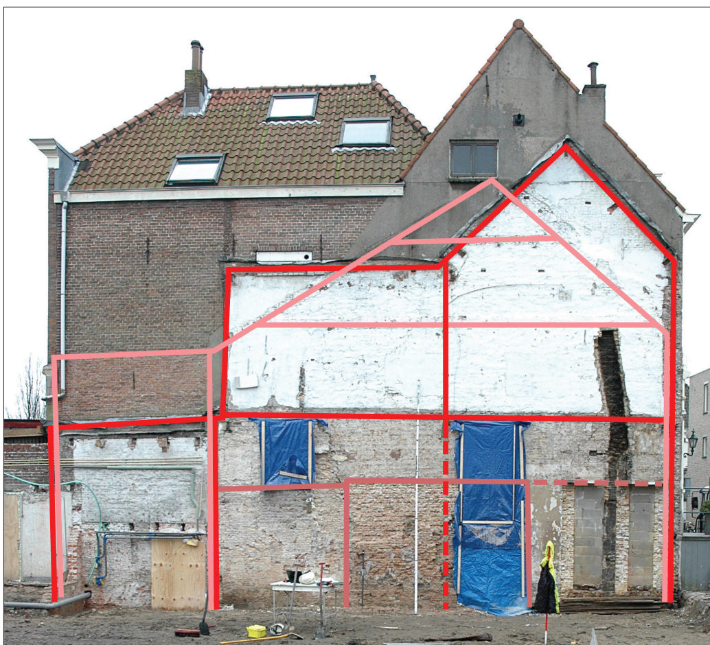
Afb. 12: Foto richting het zuiden, van de zijmuur van Nieuwstad nr. 9. De sporen van bebouwing in de muur zijn ter verduidelijking gekleurd. De met roze lijnen aangeduide sporen zijn toe te wijzen aan de bebouwing die is afgebeeld op de tekening uit 1660 (afb. 6). De paarse lijnen behoren mogelijk eveneens toe aan deze vroege fase. In rode lijnen zijn de contouren van de meest recente bebouwing aangegeven (vergelijk afb. 9 en 10).
