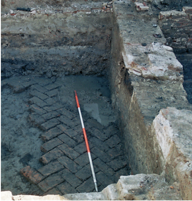
Afb. 25. Vloer (spoor 138), gelegd in keperverband, in de kelder van het Huis van Arkel, gezien naar het zuiden.
