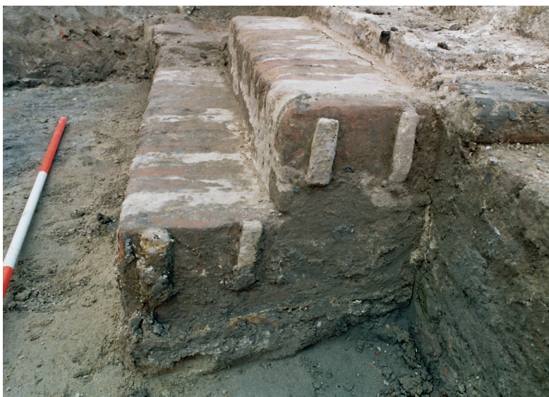
Afb. 30. Trapje (spoor 136) naar de kelder voorzien van rollagen, verstevigd met ijzeren krammen, gezien naar het zuiden.
