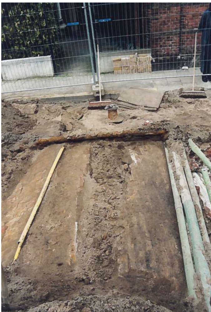
Afbeelding 20 (boven). Boog A gefotografeerd richting het westen. Op de voorgrond de verwijderde boog B. Duidelijk is de gemetselde opvulling waar te nemen tussen de twee bogen in. Het voormalige brugdek moet dun zijn geweest en is niet bewaard.
