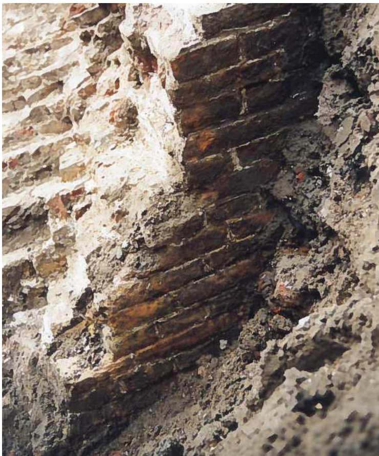
Afbeelding 24. Een detailopname van het bewaard gebleven deel van de welfconstructie en het toegepaste metselverband van boog B. Foto richting zuiden.
