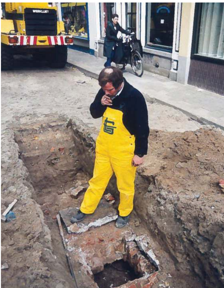
Afbeelding 29 (boven). De Burgstraat met proefsleuf 2, gewelf C van "de donkere heul" met de afdichtingssteen over het mangat verwijderd. Foto richting noordwesten.
