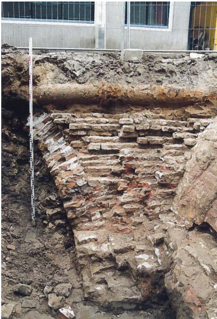
Afbeelding 25. Een opname van de opvulling tussen de welfconstructies A en B. Het metselwerk is in het verleden reeds verwijderd voor de aanleg van de ijzeren rioleringsbuis. Foto richting zuiden.
