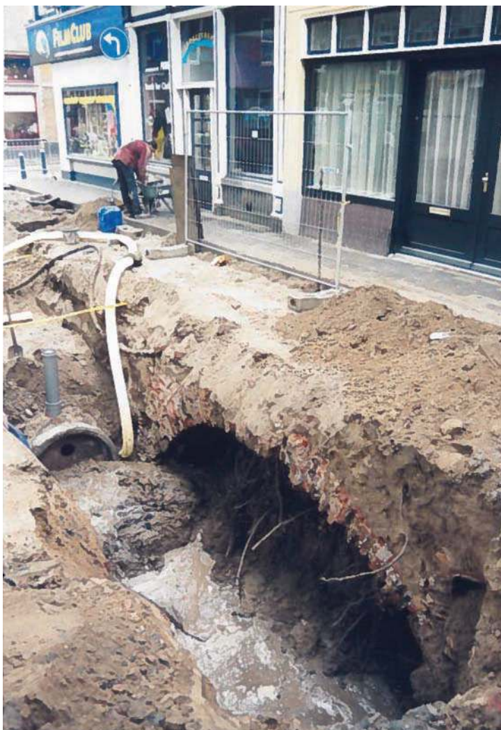
Afbeelding 31 (links). De Burgstraat met proefsleuf 2, gewelf C van “de donkere heul” doorbroken voor rioolaanleg. De doorgang in de heul was opgevuld met zand. Foto richting noordwesten.
