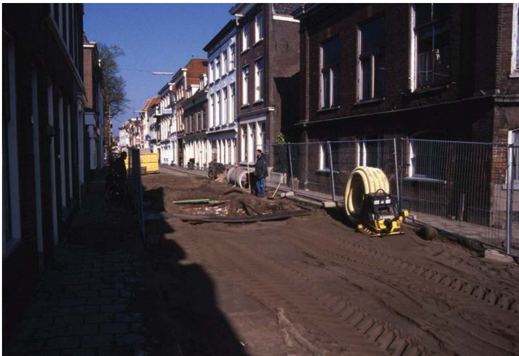
Afbeelding 2 & 3. Overzichtsfoto's van het onderzoeksgebied op 16 april 1999, richting het westen. Op de foto's is de eerste proefsleuf waarneembaar met de meest westelijke boog van een brug. De brug bevindt zich precies onder het rechtse pand, Burgstraat nr. 61. De jalon markeert de westelijke rand van de brug.
