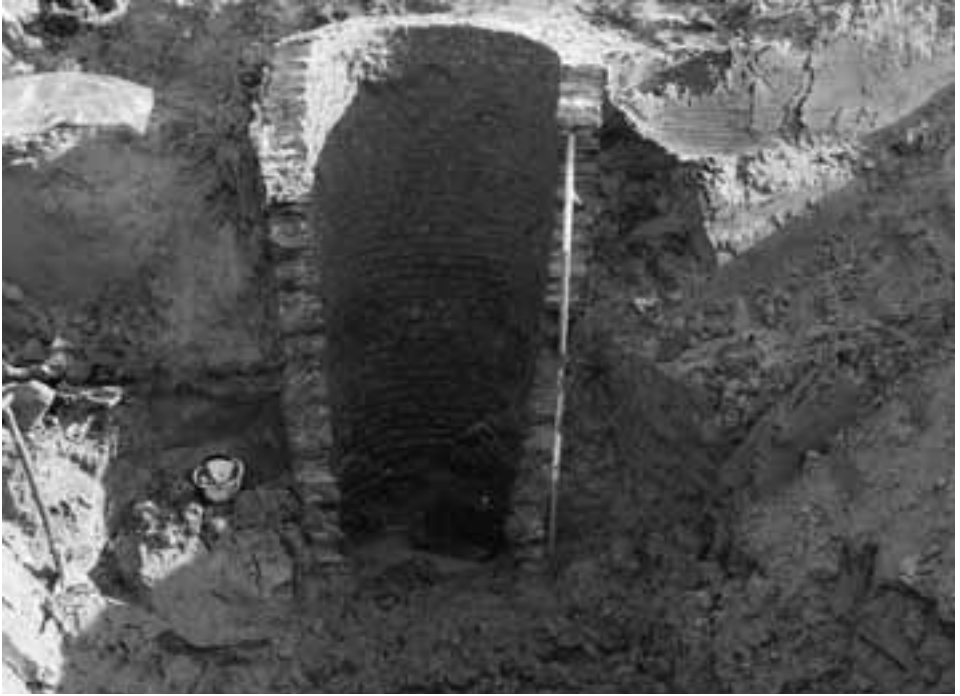
Afb. 22. Hoorn * Klooster Nieuwlicht. Stenen welput met houten rooster. Onder het rooster bevond zich een houten pijp, waardoor het welwater omhoog kwam.
