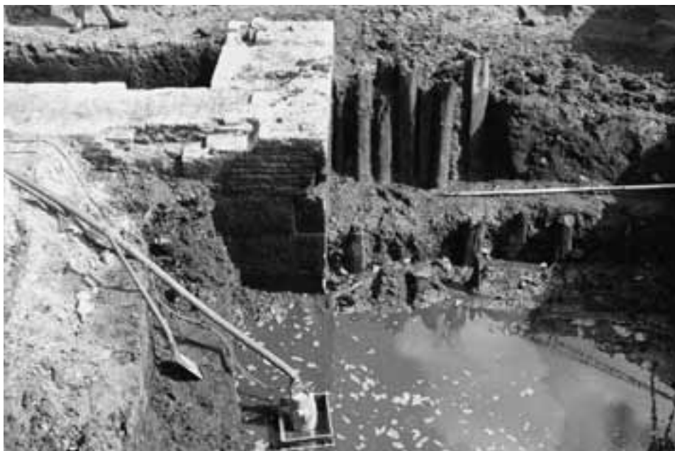
Afb. 24. Hoorn * Westervoort. De zware funderingsmuur van de 16de-eeuwse Westervoort aan de zeezijde, met aansluitend de oude houten beschoeiing van de Westerdijk in Hoorn.
